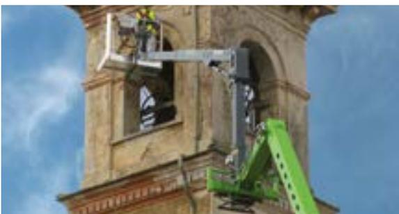
Durch das Schwenken des Arbeitsbühnenträgerarms des Systems Space ist auch der Zugang zu sonst schwer erreichbaren Punkten möglich.
