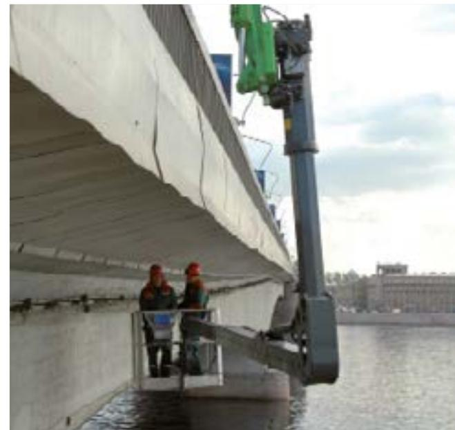
Das System Space ermöglicht auch das Arbeiten auf Höhen, die mehr als 9 Meter unter dem Straßenniveau liegen.
